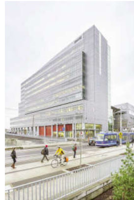
Green building: Công trình tổ hợp Life Sciences Building (Portland, Oregon, Mỹ)
